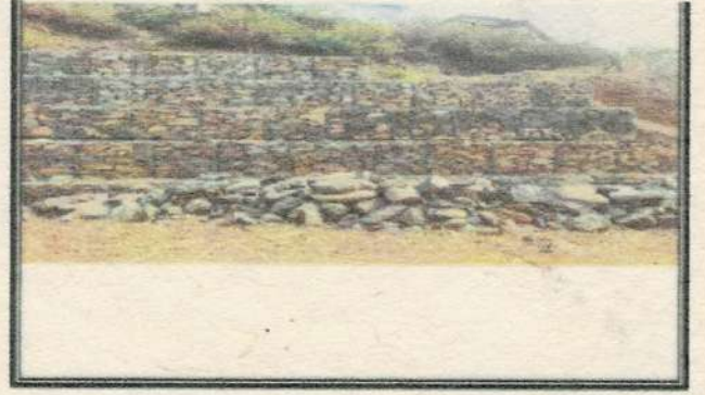
-सरस्वती मा वि टेवा पर्खाल निर्माण, आमचोक-०९
